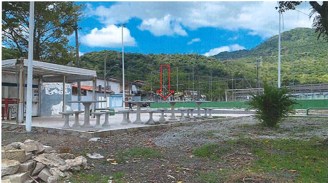
Figura 02 – Instalação de conjunto de mesas e bancos em concreto.
