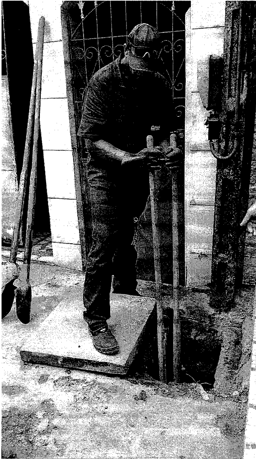
RUA SANTA FILOMENA – SITIO NOVO
